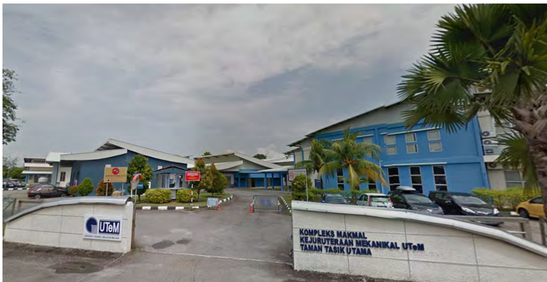
Figure 1.3: Kompleks Makmal Kejuruteraan Mekanikal (KMKM)
